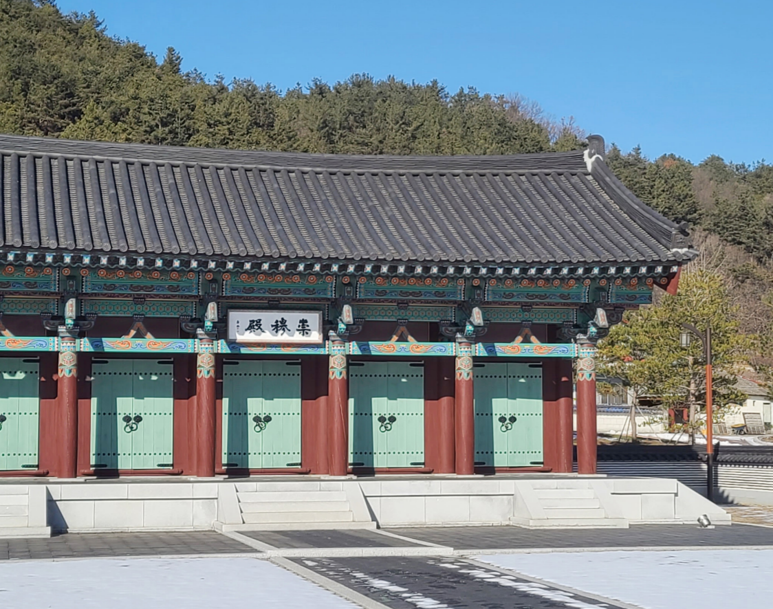
백제 왕국의 시조 온조왕을 비롯해 마지막 왕인 의자왕의 위패를 모신 사비백제대왕 송목전.
